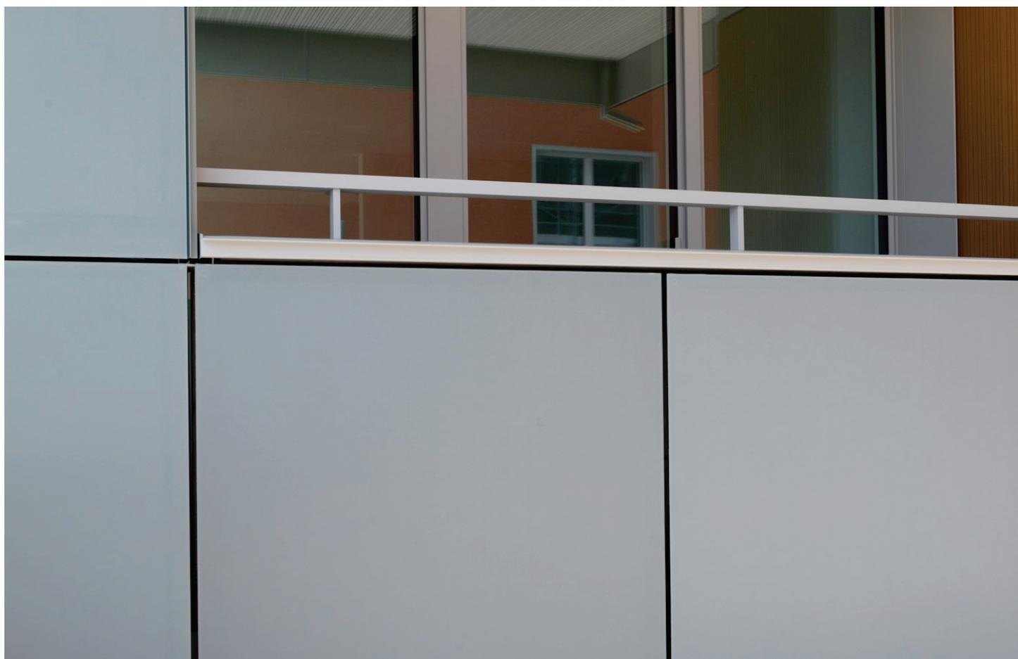
Dans le cadre d'un assainissement, cet immeuble de la Hofwiesenstrasse à Zurich a été équipé de modules PV monocristallins spécialement teintés qui rappellent plus une façade métallique matte qu'à des cellules PV. Photo : Viridén+Partner AG
