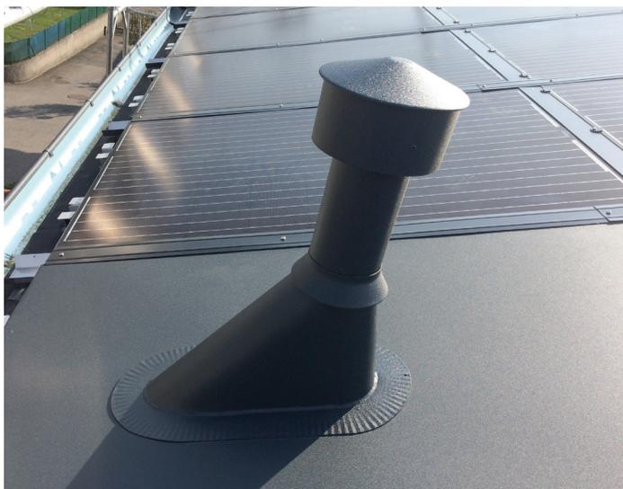
Lorsque la pose de modules PV est entravée, des surfaces passives sont intégrées et scellées avec la ferblanterie dans une étape ultérieure. Photo : Designergy
