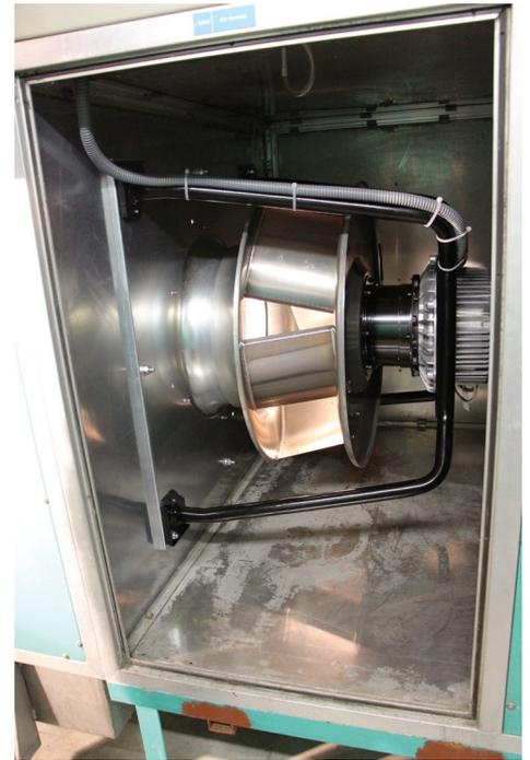
Comparaison de l'ancien et du nouveau : à gauche, un ancien ventilateur avec volute, entraînement par courroie et convertisseur de fréquence ; à droite, un ventilateur centrifuge EC moderne. Photos : ZIG/HSLU
