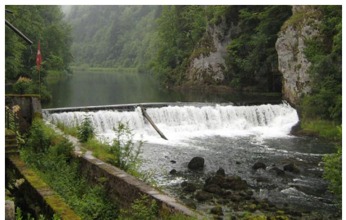
Le barrage du Theusseret, sur le Doubs (source: Association «Sauvons Le Theusseret»)
