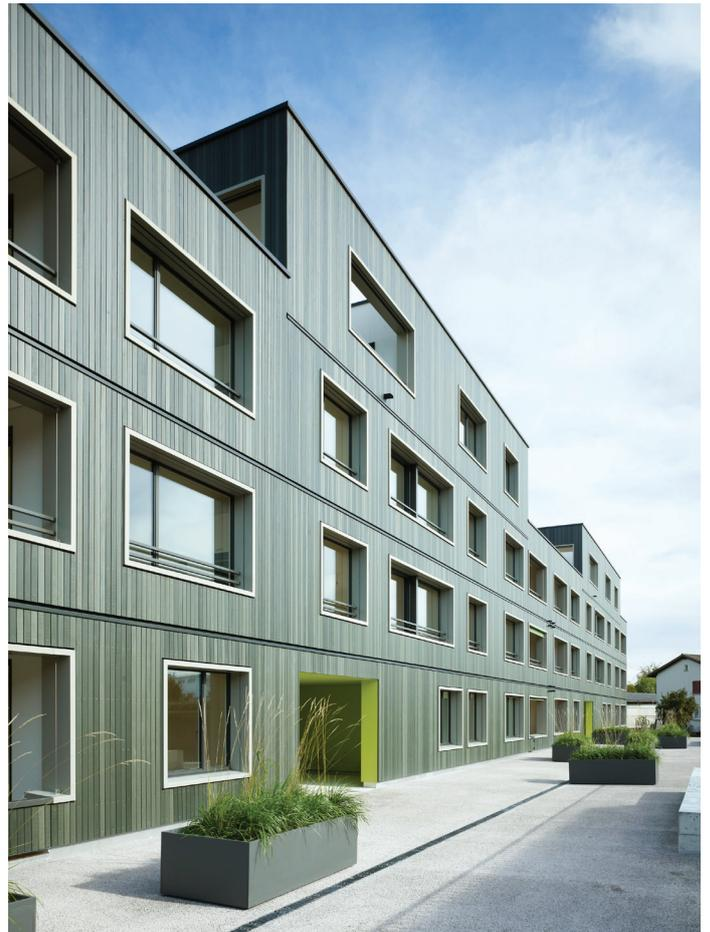
La façade de la « swisswoodhouse » à Nebikon (LU) se compose d'un coffrage en bois de pin et d'épicéa. Une installation photovoltaïque de 160 m<sup>2</sup> d'une puissance de 26 kWp est installée sur le toit. Photo : Ruedi Walti, Bâle
