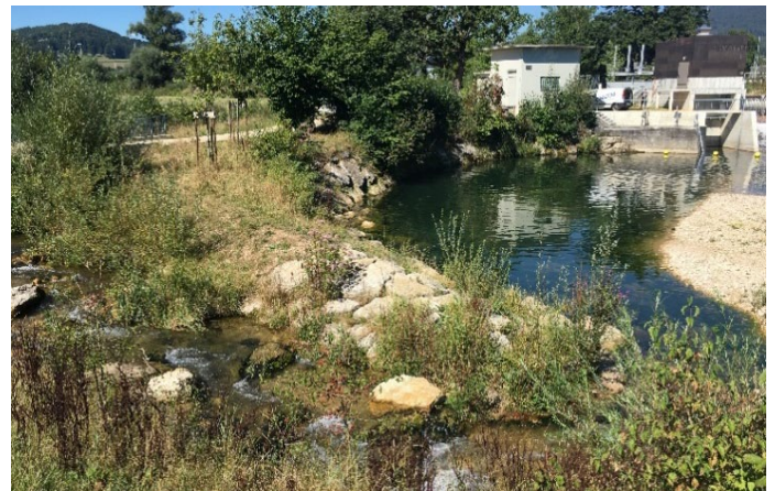
Embouchure du chenal de contournement du seuil de la Grande Ecluse (Delémont, JU) pour la montaison et la dévalaison des poissons (cf. brève) (photo: SID)
