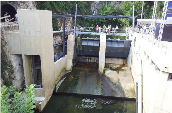
Ascenseur à poissons de la centrale des Moulins (Orbe, Vaud, CH) (photo: Mhylab)
