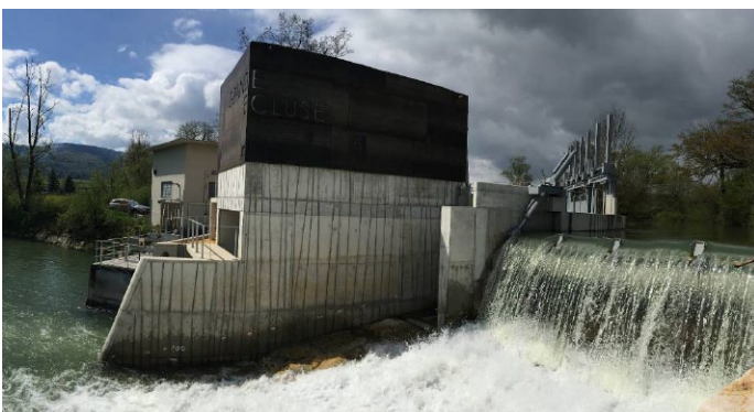
Centrale de la Grande Ecluse à Delémont JU (photo: SID)
