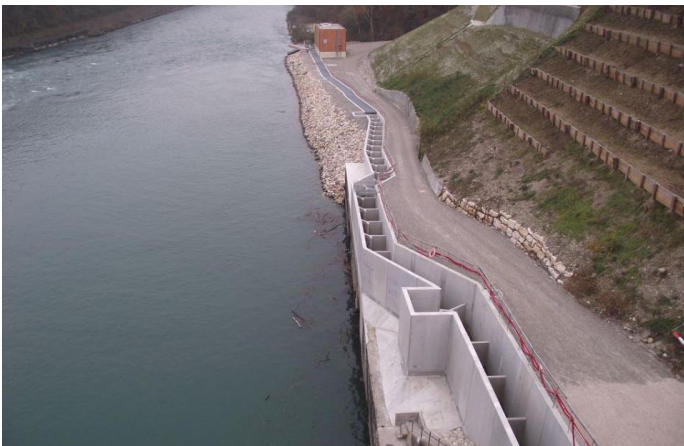
Echelle à poissons de Chancy-Pougny (canton de Genève et France), sur le Rhône, et local de turbinage du débit d'attrait (photo: SFMCP)
