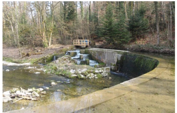
Passe à poissons à bassins successifs sur l'Arnon au Moulin de Péroset (Fiez, Vaud), attenante au canal d'amenée (photo: Mhylab)
