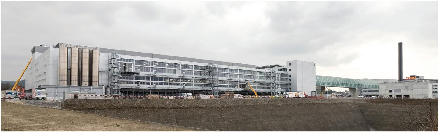
La nouvelle construction dans le centre logistique de Coop à Schafisheim (AG) héberge 23 lignes de production pour la fabrication de produits de boulangerie et de pâtisserie. Les fours sont chauffés à l'huile thermique, elle-même chauffée dans la centrale énergétique (à droite avec cheminée) par une innovante chaudière à biomasse. Photo : Coop
