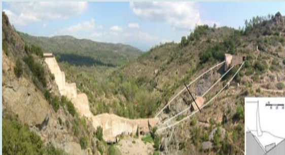
Malpasset (France), défaillance au niveau de la fondation lors de la première mise en eau
