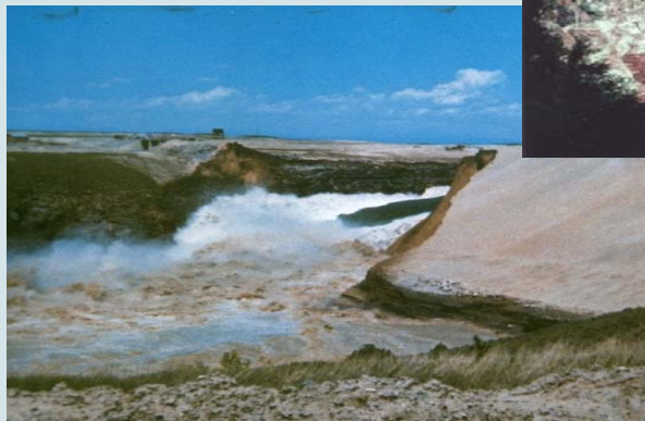
Teton Damm (Etats-Unis) Erosion interne
