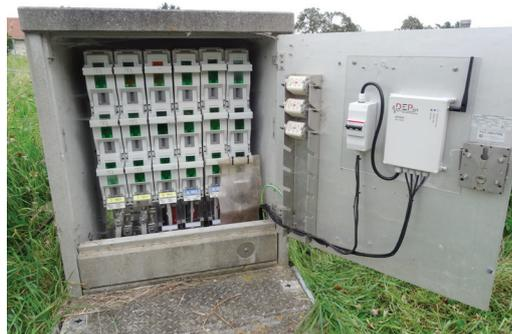
Boîtier de distribution avec un module Grid-Eye. Photo : DEPSys
