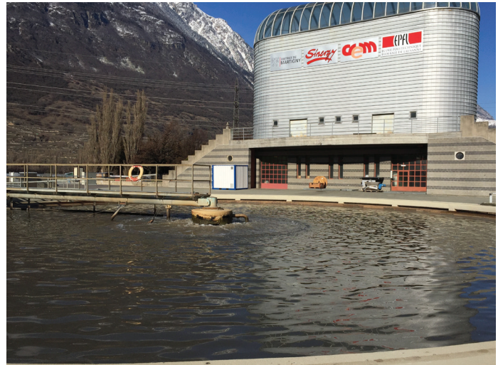
Dans ce bâtiment à proximité de la station d'épuration de Martigny, les scientifiques de l'EPFL étudient comment une batterie à flux Redox peut être utilisée directement pour la production d'hydrogène. Photo : B. Vogel
