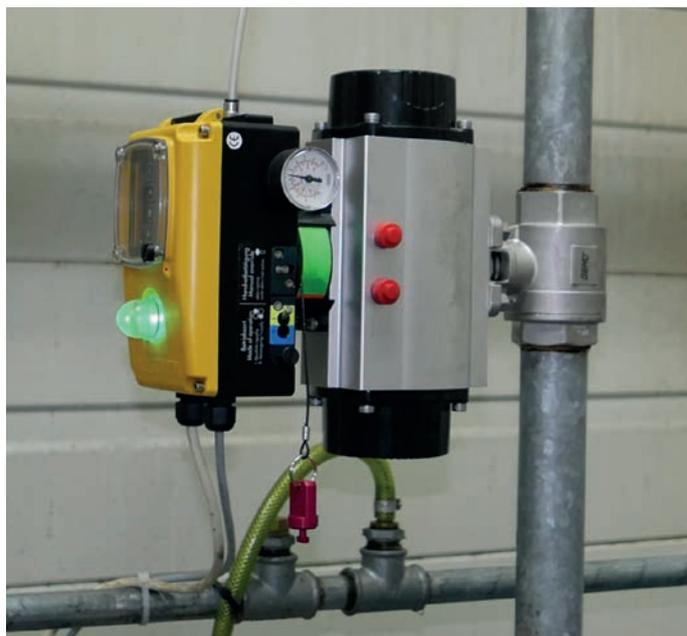
*Le découplage automatique du réseau de conduites en dehors des heures d'exploitation au moyen de robinets à bille à commande électrique constitue un potentiel d'économie précieux. Il prévient avec efficacité les pertes dues aux fuites qui surviennent à 95% en aval de la centrale d'air comprimé.*
