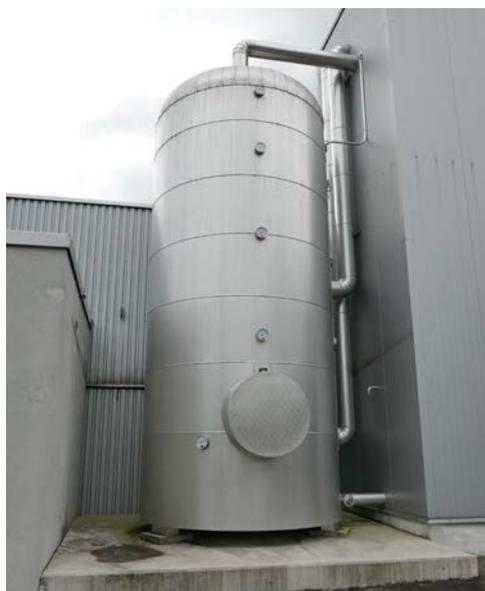
*La chaleur dégagée par l'air comprimé chauffe l'accumulateur de chaleur de 30 000 litres pendant toute l'année, avec un niveau de température compris entre 60 et 90 °C.*
