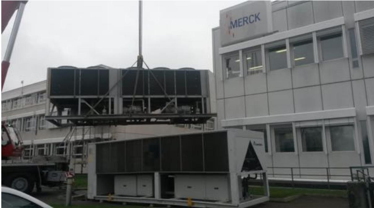
*Démontage et évacuation de l'ancienne machine de froid.*
