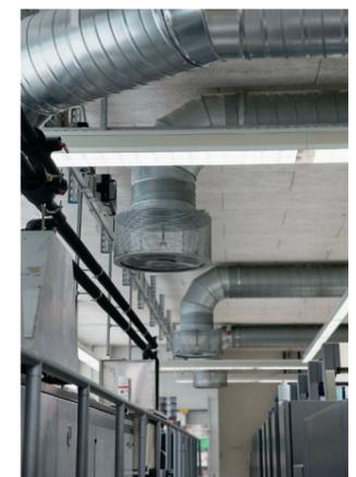
L'imprimerie von Ah récupère l'air chaud des machines à imprimer et l'utilise pour chauffer tout le bâtiment.
