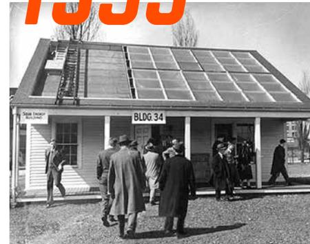
«Solarhouse I», une sorte de précurseur de la maison écologique construite en 1939 par Hoyt Hottel, servit de laboratoire expérimental sur le campus du Massachusetts Institute of Technology (MIT). C'était la première maison chauffée activement par l'énergie solaire, au moyen d'un capteur solaire à quadruple vitrage placé sur le toit. En hiver, le rayonnement du soleil était utilisé comme source de chaleur et en été, on s'en servait pour produire du courant pour un climatiseur.
