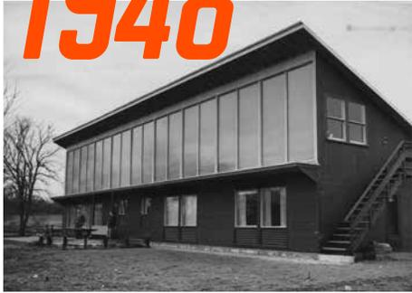
La «Dover Sun House» de 1948 fut la première maison pour laquelle fut réalisé, en plus de l'utilisation de capteurs plans, un concept d'énergie solaire passive.
