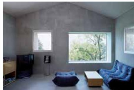
Savioz a remplacé les éléments de la façade, autrefois faits de planches de bois aboutées, par un mur monolithique en béton apparent assorti d'un coffrage en planches de bois, réinterprétant ainsi l'ancienne structure en bois.
