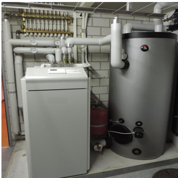
Figure 25 : Unité intérieure d'une pompe à chaleur Inverter
