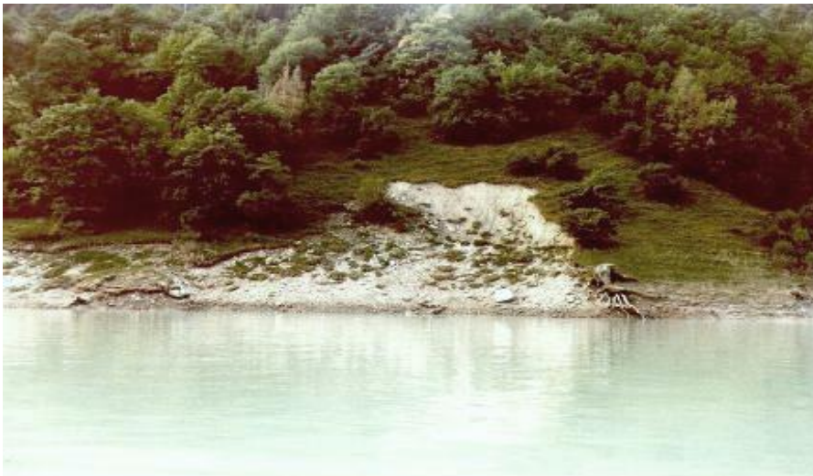
Figure 8e : Instabilité de la rive
