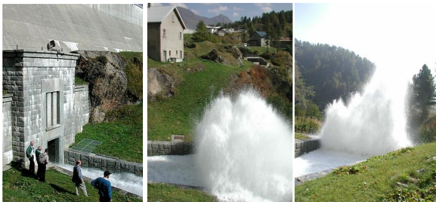
Figure 10 : Essai de fonctionnement d'une vidange de fond
