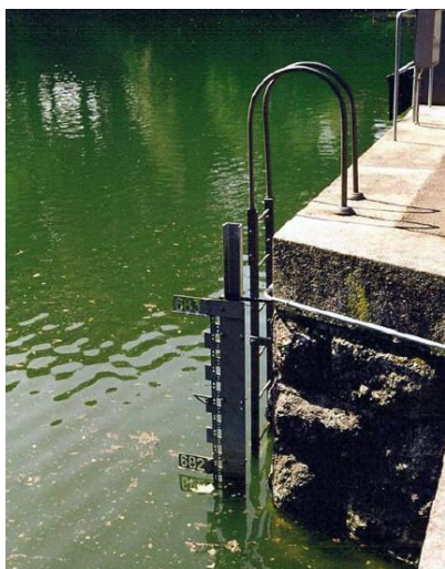
Figure 9 : Echelle limnimétrique pour la mesure du niveau d'eau
