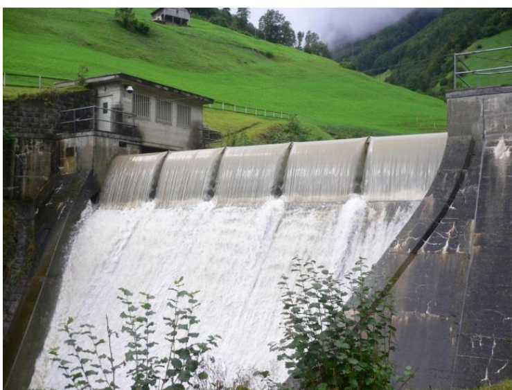
Figure 5 : Evacuateur de crues ouvrage d'accumulation
