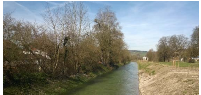
Canal de fuite de la petite centrale de Hard (ZH)
