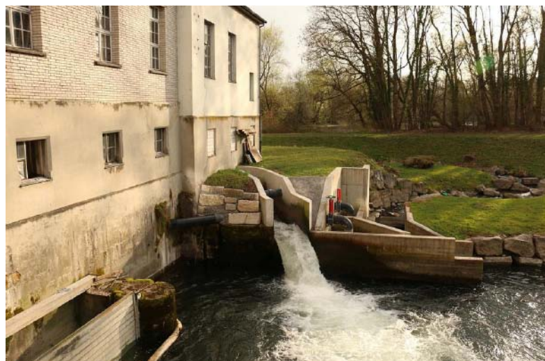
Canal de dérivation permettant la dévalaison des poissons et canal de dérivation à la centrale de Stoppel (AG) sur la Limmat .
