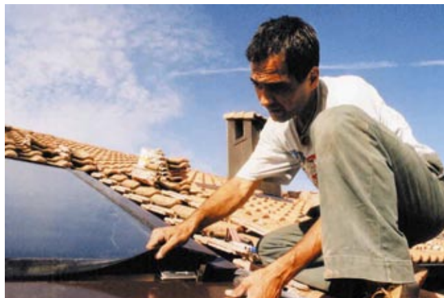
Le gaz naturel et l'énergie solaire chauffent la maison.
