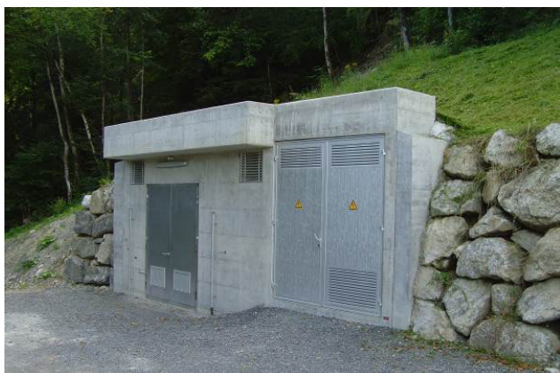
Le local de turbinage de Châble II intégré au réseau d'eau potable de la commune de Vionnaz (© Commune de Vionnaz)
