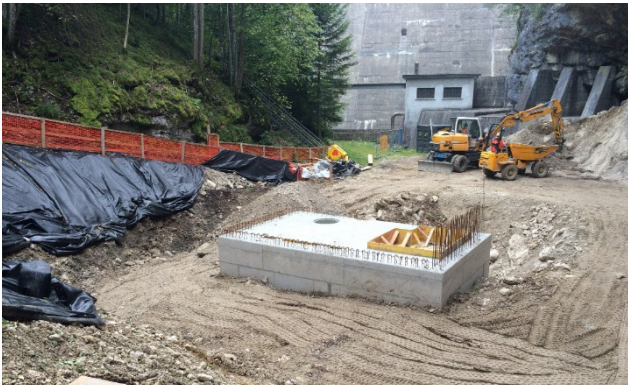
Le local de turbinage semi-enterré, en pied de barrage, de la petite centrale de dotation du Day en construction, en septembre 2014 (© Romande Energie)
