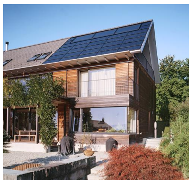
Figure 2: Système solaire photovoltaïque intégré au bâtiment en Suisse, Mettmenstetten
