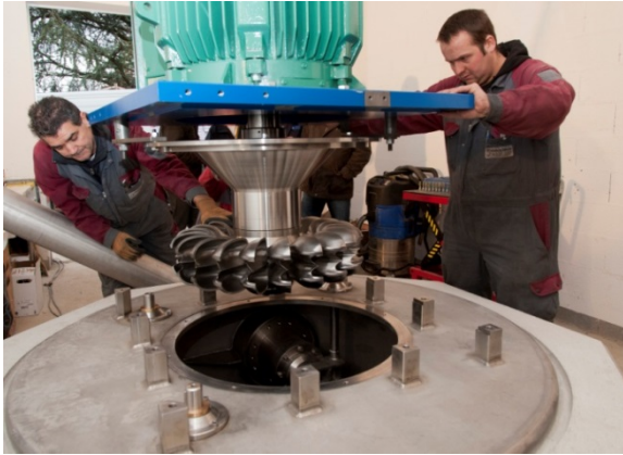
Montage sur site du turbogroupe de SITSE (VD) (Copyright: Jacquier Luisier SA, www.sitse.ch/newlepuration.php )
