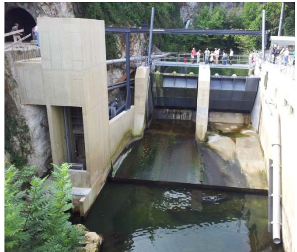
Centrale des Moulinets à Orbe (VD) : la passe à castors, l'ascenseur à poissons, le seuil équipé de vannes clapet et le local de turbinage (Copyright : Mhylab)
