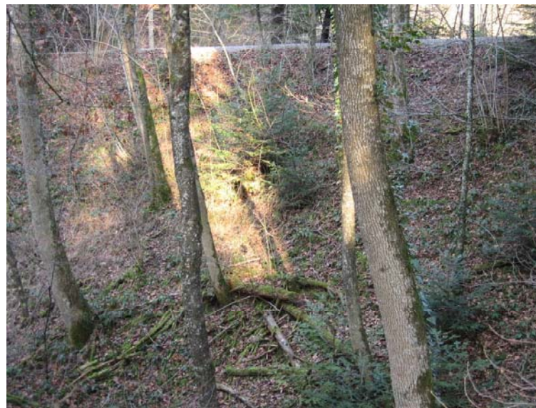
Supprimer les arbres sur la digue
