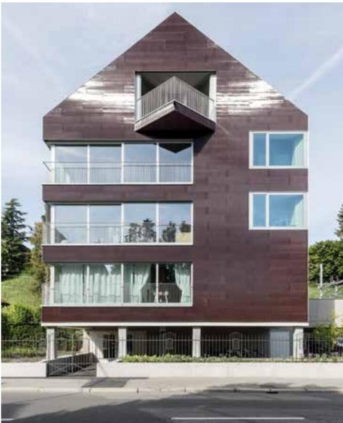
La chute massive des prix a permis aux modules PV de devenir concurrentiels en remplacement de couches de protection contre les intempéries traditionnelles. Dans les façades, ils constituent une alternative à des plaques de pierre, des panneaux métalliques ou des vitres. Sur le toit, ils rem-
