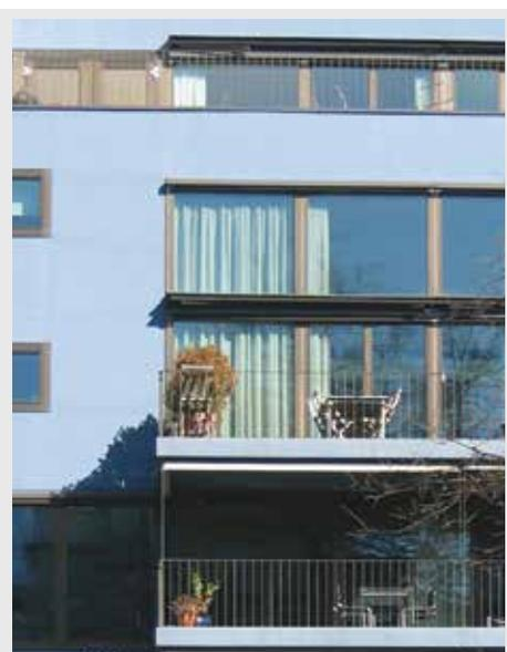
*Illustration 3.3: Les balcons apportent un ombrage considérable aux fenêtres orientées sud. Considérée sur la période de chauffage, la façade de fenêtres derrière les balcons entraîne une perte d'énergie équilibrée de  $33 \text{ kWh}/\text{m}^2$ . Sans l'ombrage des balcons, il en résulte un apport d'énergie de  $19 \text{ kWh}/\text{m}^2$ . La différence de  $52 \text{ kWh}/\text{m}^2$  de la surface des fenêtres correspond à un pouvoir calorifique d'environ 5 litres de mazout.*
