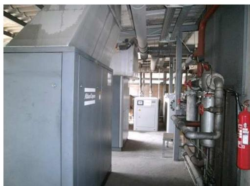
Les compresseurs d'air de nouvelle génération consomment essentiellement moins d'énergie, car ils n'utilisent que l'électricité nécessaire pour atteindre la pression d'air définie. Les modèles d'ancienne génération tournent également par moments à vide et ne peuvent pas réguler leur vitesse en fonction de l'utilisation demandée.
