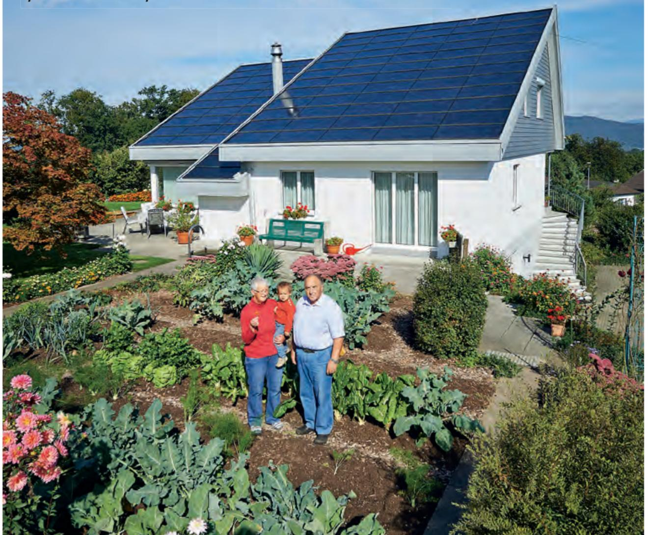
Les Flubacher produisent leur propre électricité – via une centrale photovoltaïque intégrée au toit.
