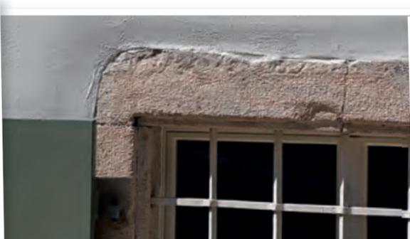
Le crépi à base d'aérogel s'applique sur les anciens bâtiments en couche si fine que les chambranles des fenêtres ne sont pas recouverts.
