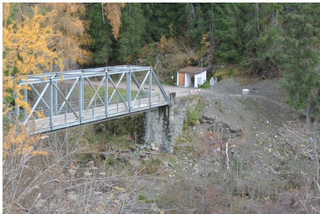
La petite centrale des eaux minérales de Funtana Cotschna
