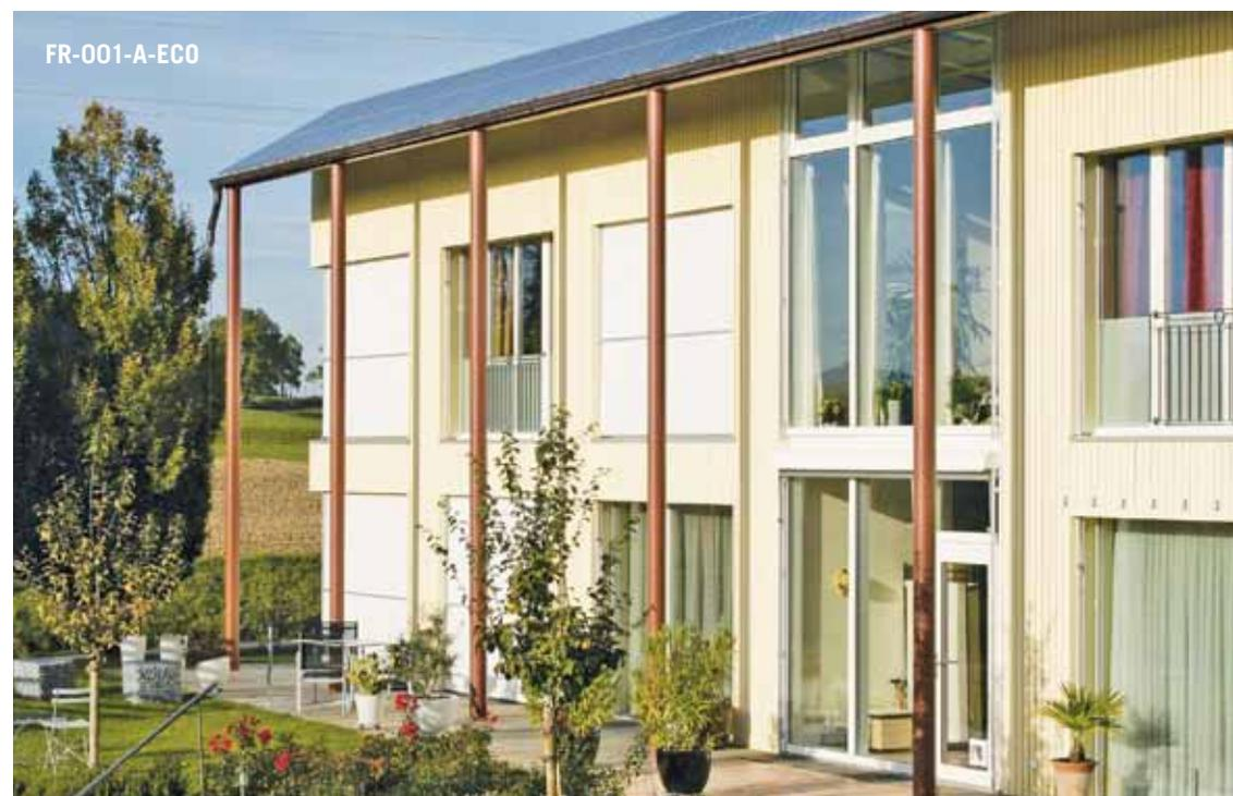
La maison est constituée de deux parties reliées par un jardin d'hiver totalement vitré. Une seule partie possède un sous-sol, l'autre repose sur une semelle filante. L'enveloppe extérieure a été remplie de 40 cm de fibres de cellulose pour une bonne isolation. Les murs en bois protègent
