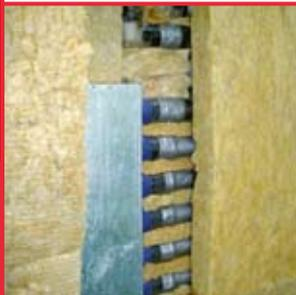
**Caisson de répartition d'air installé dans l'espace clos d'un agencement de cuisine**
