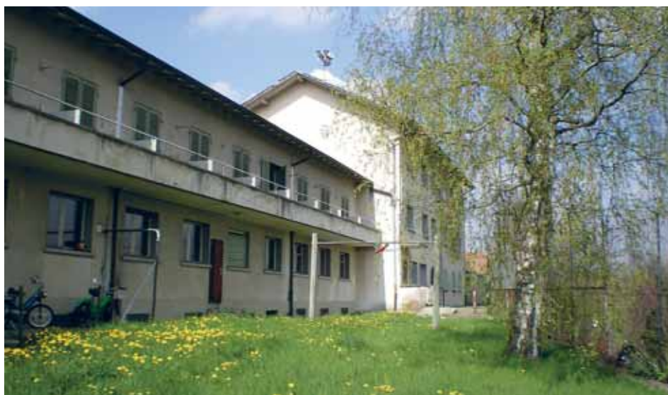
Illustr. 126 Le bâtiment avant sa rénovation. (© Lutz architectes)
