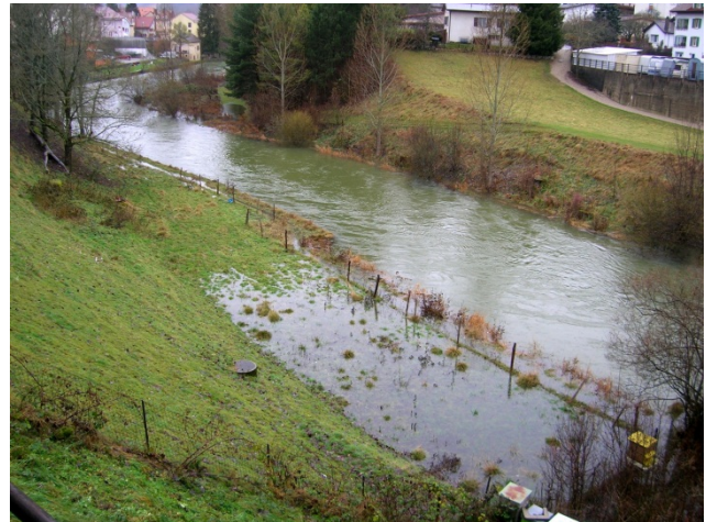
Site de la Foulaz : zones inondées par débit moyen (env. 25 m 3 /s) (avant réhabilitation)
