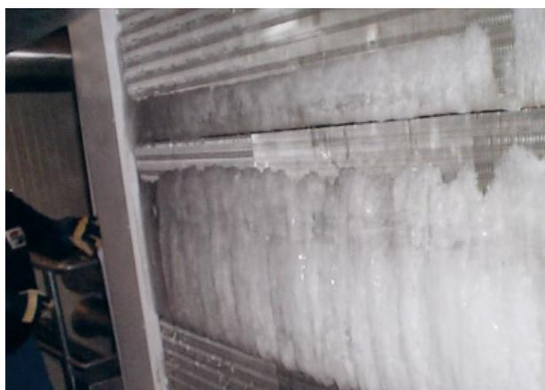
Photo: Évaporateur givré. L'air ne traverse plus qu'une partie de la surface.
