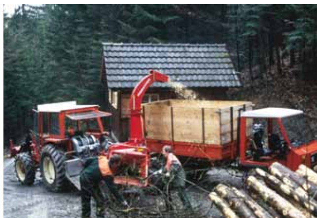
Préparation de plaquettes de bois en forêt. Ces derniers sont ensuite transportés au silo du chauffage.
