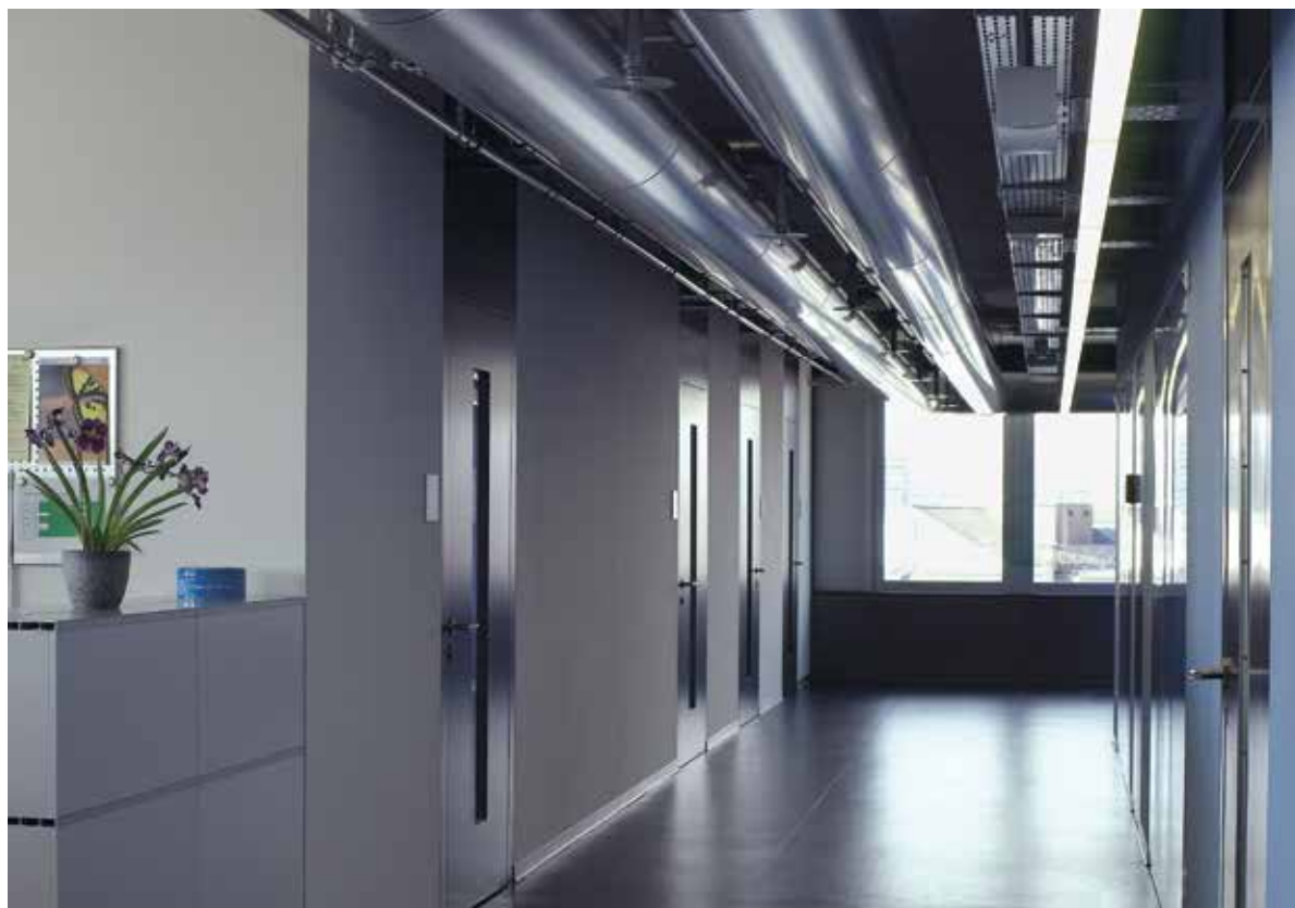
Illustration 6.21: Vue intérieure du centre administratif Werd.
