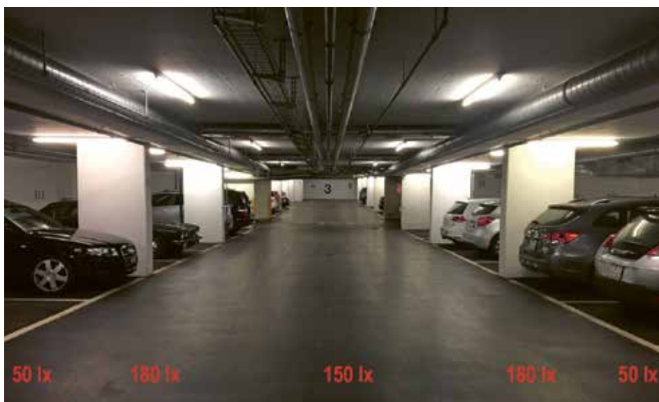
Illustration 6.19: L'éclairage et le niveau d'éclairage mesurés avant la rénovation.
