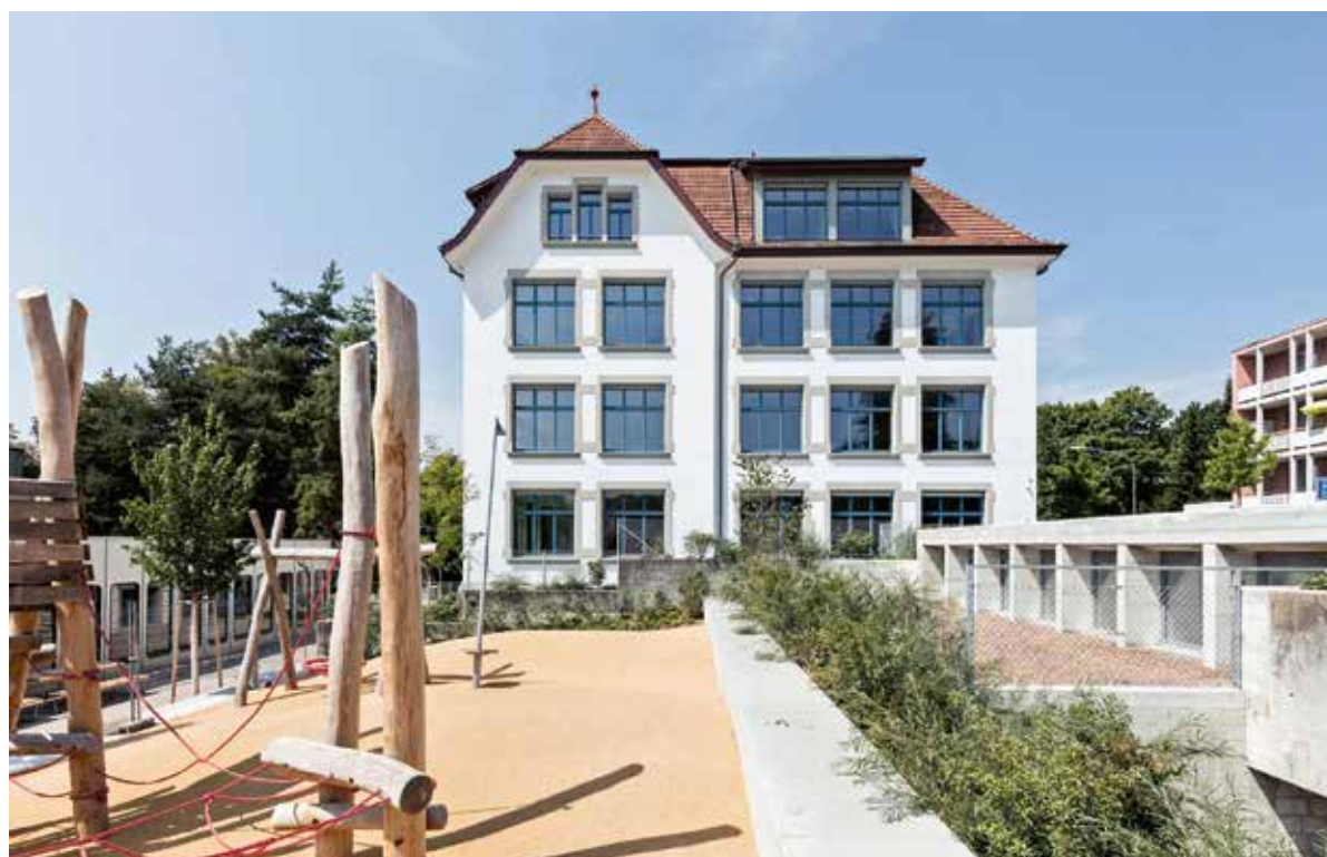
Illustration 8.29: Vue extérieure du bâtiment scolaire Bläsi rénové à Zurich-Höngg.
