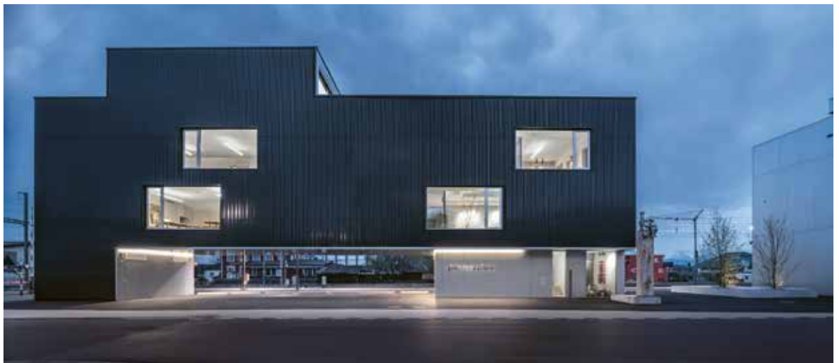
Illustration 8.32: Architecture du bâtiment, caractérisée par son emplacement entre la voie ferrée et la rue. (Image: Zumtobel)
