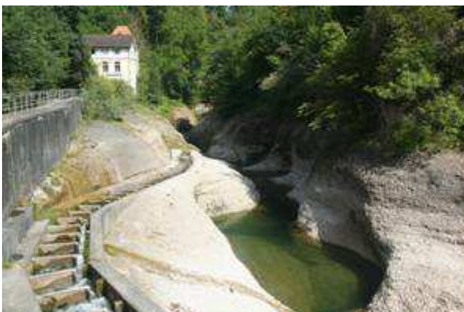
La petite centrale de Soor sur la Thur (© Programme PCH)
