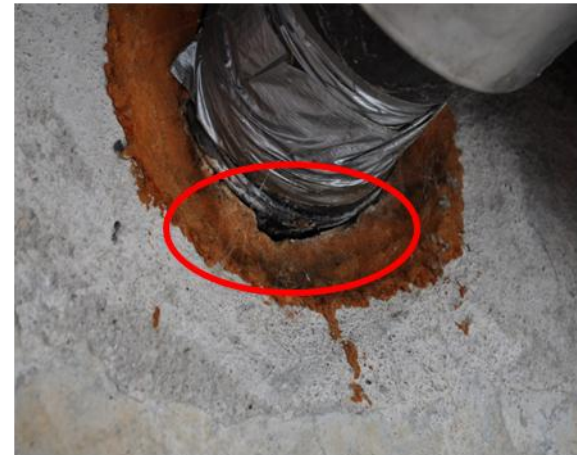
Unsachgemässe Rohrabdichtung
