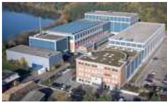
Le dépôt intermédiaire pour déchets radioactifs de Würenlingen. Source: ZWILAG
