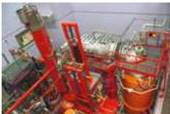
Installation à plasma dans la halle du four au dépôt intermédiaire central ZWILAG. Une partie des déchets faiblement et moyennement radioactifs est vitrifiée dans cette station d'incinération et de fusion. Source: ZWILAG
