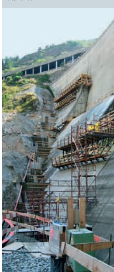
Travaux de confortement sur le barrage des Toules.
