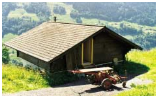
Le réservoir de Troistorrents, se différenciant à peine d'un chalet.
