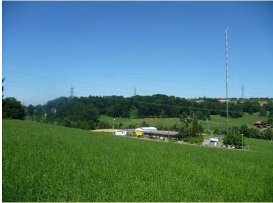
Depuis les résidences ouvrières de Krähenfeld avec vue sur la centrale de conduite du réseau (site d'observation 2)
