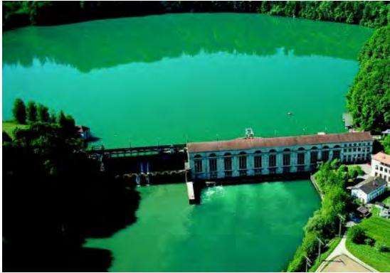
Centrale hydraulique de Mühleberg et pont du barrage
