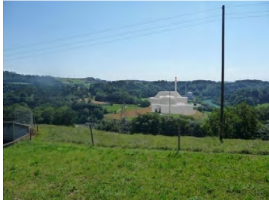
De la Matzwilstrasse en direction de Frieswil à l'entrée du hameau de Salvisberg avec vue sur (montage photo, B+S) le réacteur et la tour de refroidissement hybride de l'EKKM
