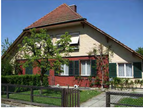
Immeuble de deux logements des résidences ouvrières de Krähenfeld aux façades en fibrociment jaune et rouge foncé
