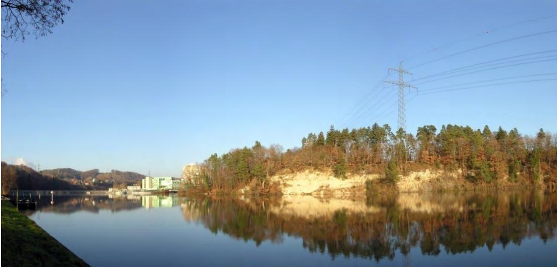
La largeur du canal d'amenée est de 66-68 m et la largeur du fond du lit est de 43-44 m (Présentation 4.8-2). La profondeur de l'eau fait partout 6.3 m. L'inclinaison de berge fait 2:3.
