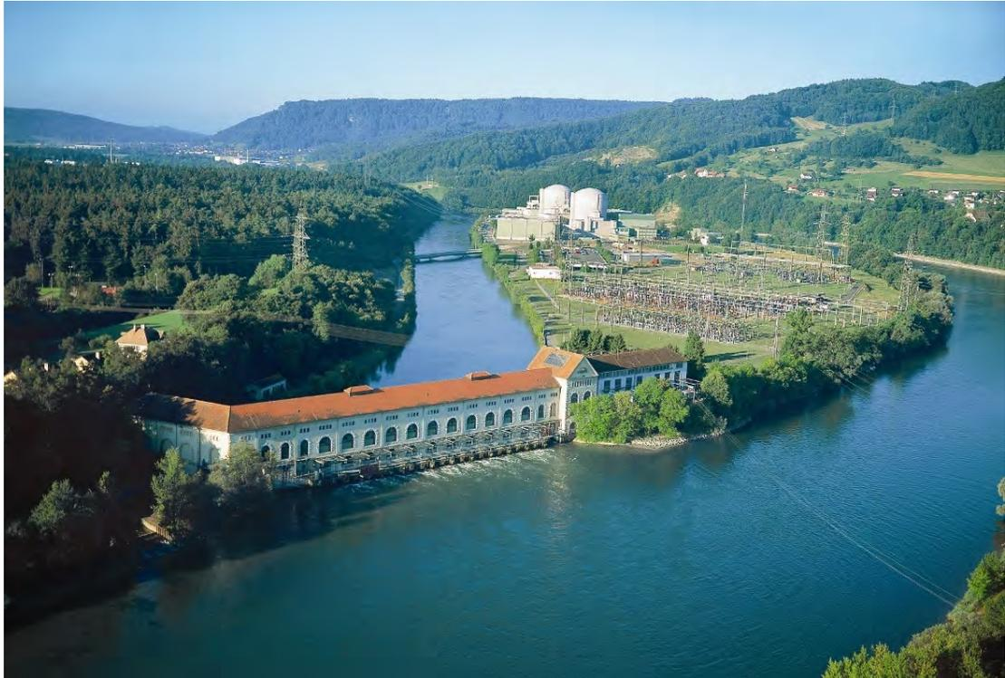
Au premier plan se trouve la centrale hydraulique de Beznau. Au centre, le poste de couplage du réseau de lignes à haute tension et le bâtiment de l'ancien centre régional de contrôle du réseau. Le poste de couplage sera déplacé vers Stüdliehau (la zone verte au sud des habitations, au milieu de l'image, à gauche).
