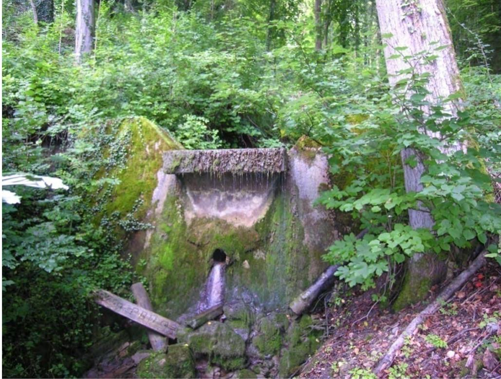
Présentation 4.8-9 : Ruisseau Chaltbründlibach, canal à forte pente dans des semis-tuyaux en béton
