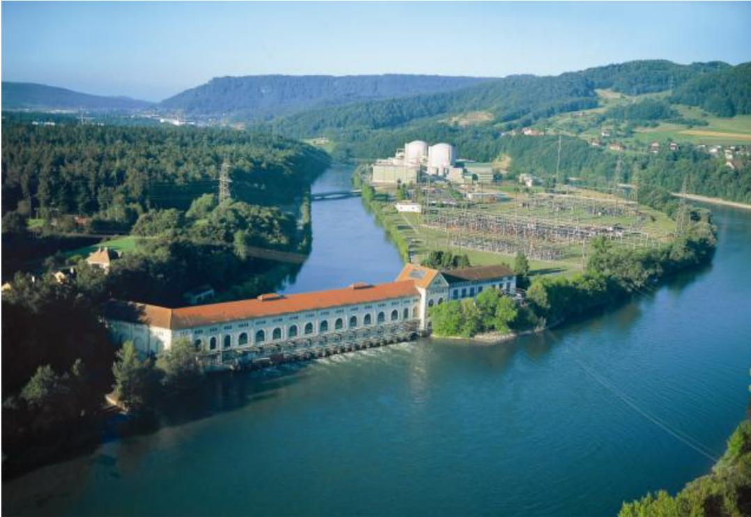
L'usine hydroélectrique de Beznau au premier plan et derrière elle l'installation de distribution du réseau à haute tension et le bâtiment de l'ancienne conduite du réseau régional. L'installation de distribution sera déplacée vers le Stüdlhau (la surface verte au sud des maisons d'habitation, au milieu de l'image à gauche).
