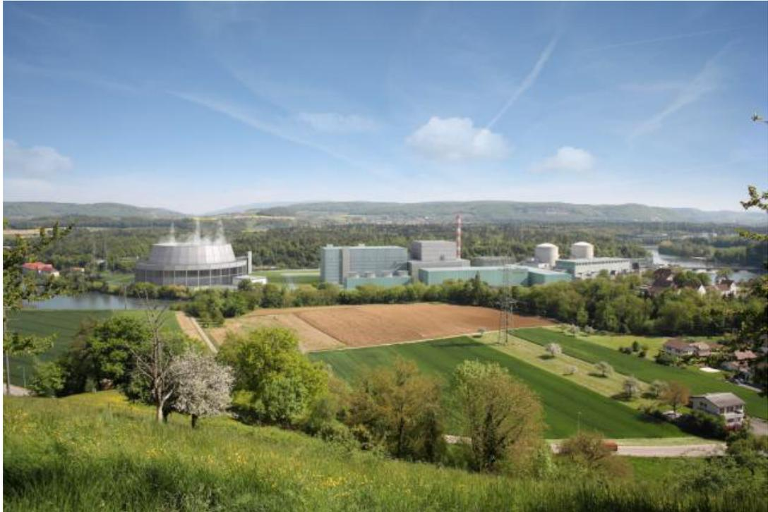
De gauche à droite : la tour de refroidissement, le bâtiment des machines avec les unités d'eau de refroidissement auxiliaire au premier plan, le bâtiment-réacteur et le bâtiment annexe au réacteur (avec la cheminée d'évacuation). L'entrepôt pour les éléments combustibles irradiés se trouve à l'avant, à côté de l'entrepôt pour les déchets de faible et de moyenne activité. Tout à droite, les centrales KKB 1 et 2.
