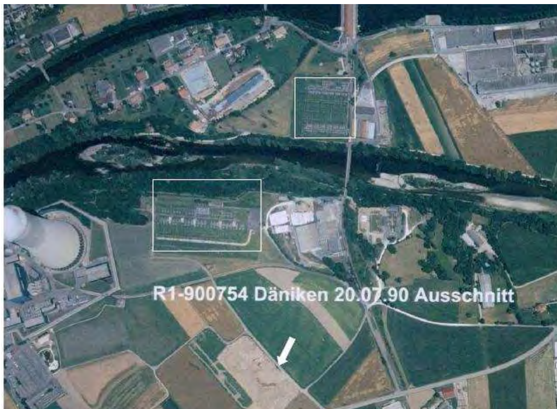
Figure 4.6-4: Photo aérienne du 20 juillet 1990 (Luftbild Schweiz 1920-2007). Les postes électriques en plein air sont encadrés de blanc. La flèche blanche indique les modifications survenues sur l'aire partielle sud.
