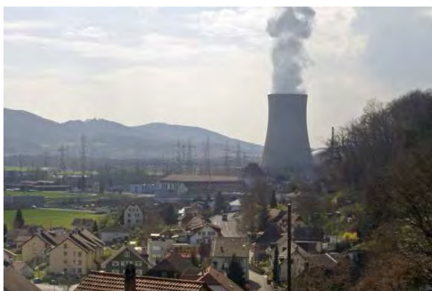
Vue de Niedergösgen, au nord de l'école. Distance 2,3 km environ
