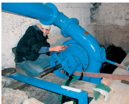
Montage de la nouvelle turbine
