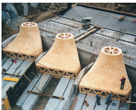
Les travaux lors de l'assainissement. Photo : Iteco
