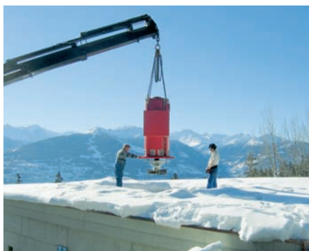
Installation de la turbine. Photo : commune de Savièse et Gasa SA
