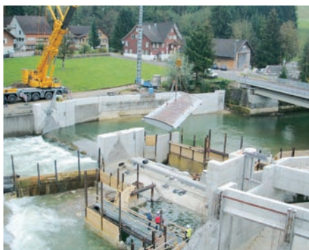
Intégration de la deuxième trappe du seuil en automne 2009 sur la centrale agrandie de Mühlau sur la Thur à Bazenheid (SG)
