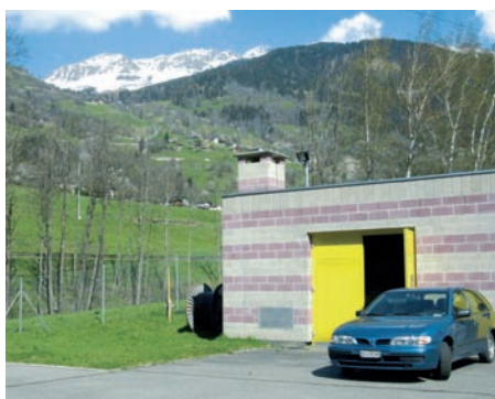
Les eaux usées sont turbinées dans ce bâtiment. Photo: Mhylab
