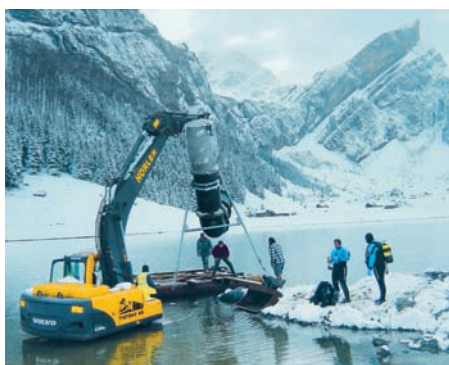
Travaux de rénovation en 2005
