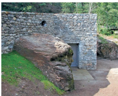
La centrale d'eau potable construite dans le style des maisons tessinoises traditionnelles. Photo : Premel SA
