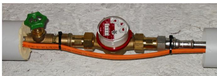
Fig. 5 : Une telle disposition crée un « bouchon de froid » et entraîne de grandes pertes thermiques malgré la présence du ruban chauffant. L'isolant devrait être continu et ne laisser que deux petites ouvertures, l'une pour la vanne et l'autre pour l'écran du compteur. Photo : J. Nijpkow
