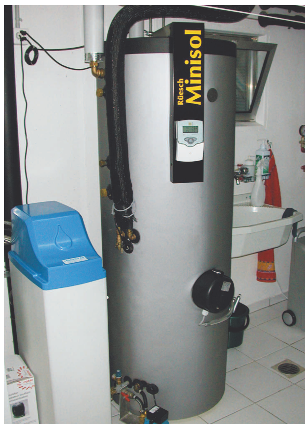
Exemple de kit solaire au sous-sol d'une habitation Photo Rüesch
