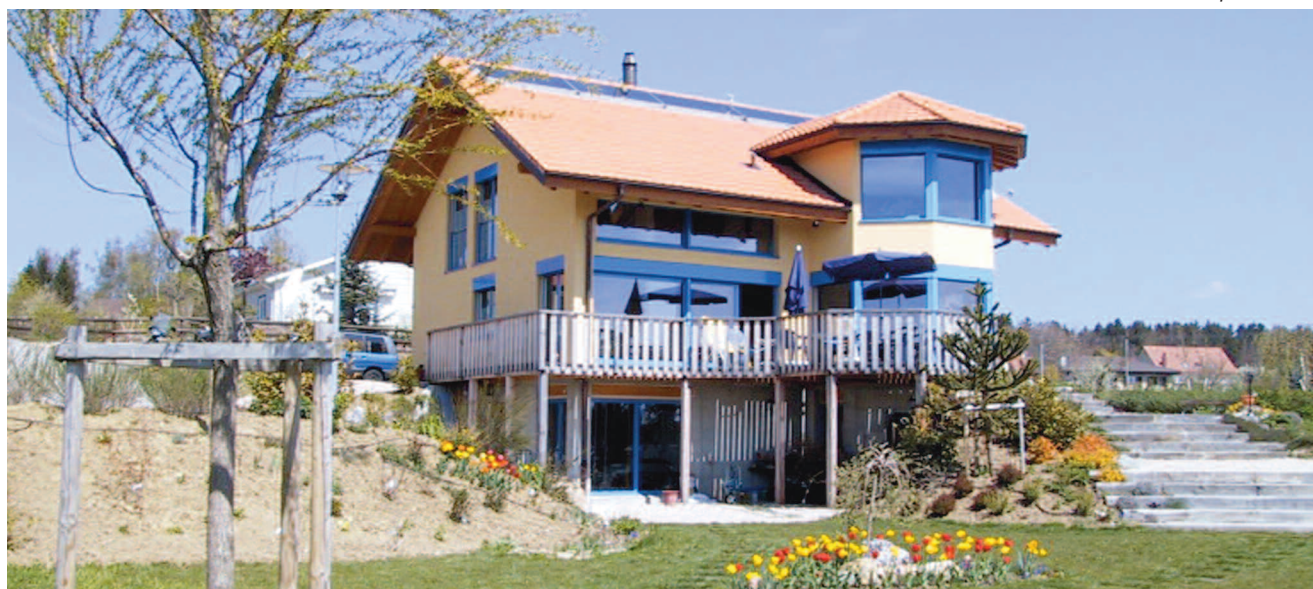
Villa MINERGIE à Chapelle / FR
