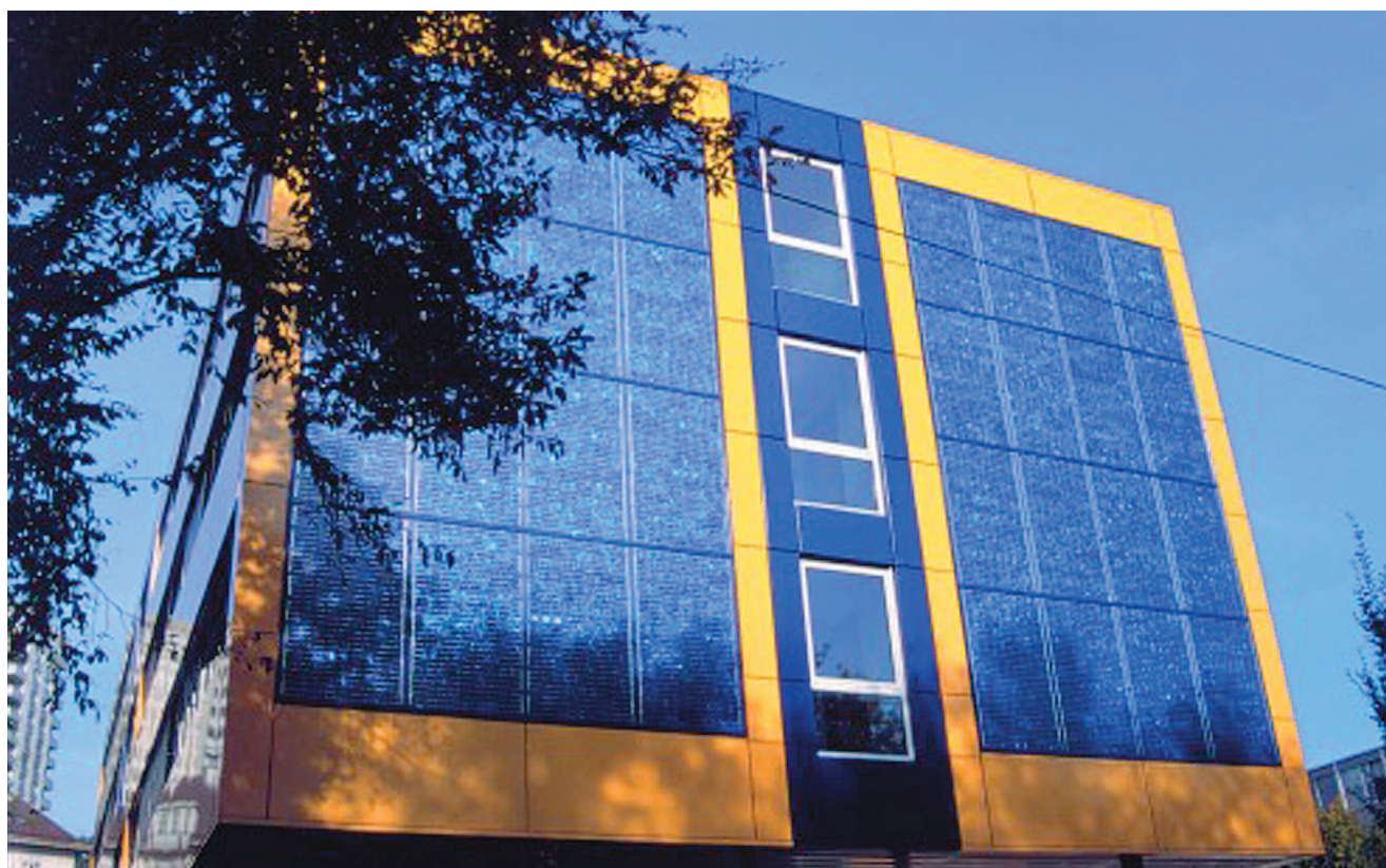
Production de courant photovoltaïque à la Maison pour étudiants, Vidy, Lausanne (Photo SSES)
