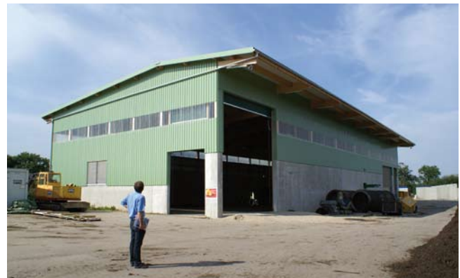
Halle de réception des déchets organiques. Source: Eric De Lainsecq (Domotech)
