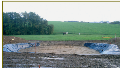
Ouverture du chantier (09.2006)
