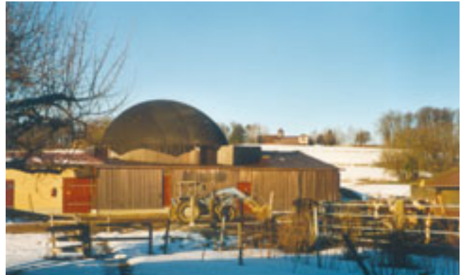
Installation de biogaz à Puidoux
