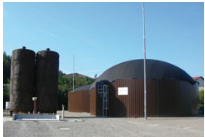
Vue générale de l'installation
